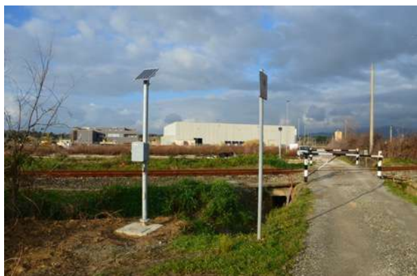
Figure 5 - Veduta dell'accesso dall'incrocio con la ferrovia
