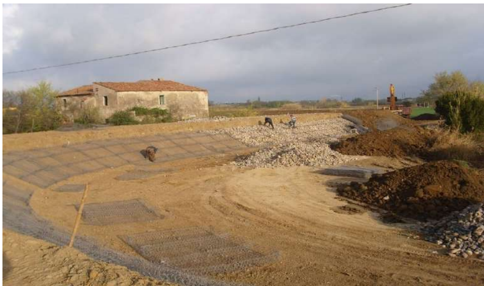
Figura 4.2.3 Immagine dei lavori di messa in sicurezza dell'argine del Cecina
