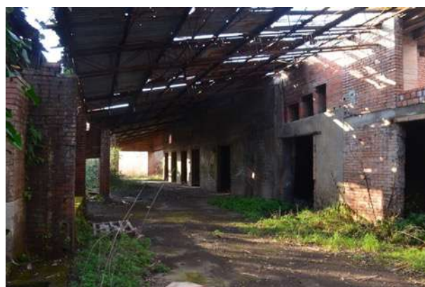
Figure 12 - Veduta delle strutture abbandonate della ex produzione
