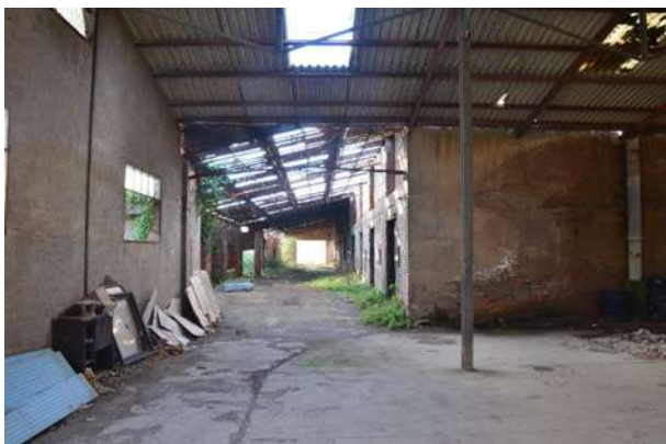
Figure 9 - Veduta delle strutture abbandonate della ex produzione
