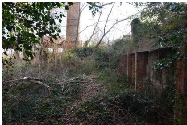
Figure 10 - Veduta delle strutture abbandonate della ex produzione
