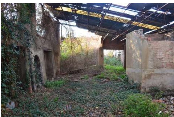
Figure 11 - Veduta delle strutture abbandonate della ex produzione
