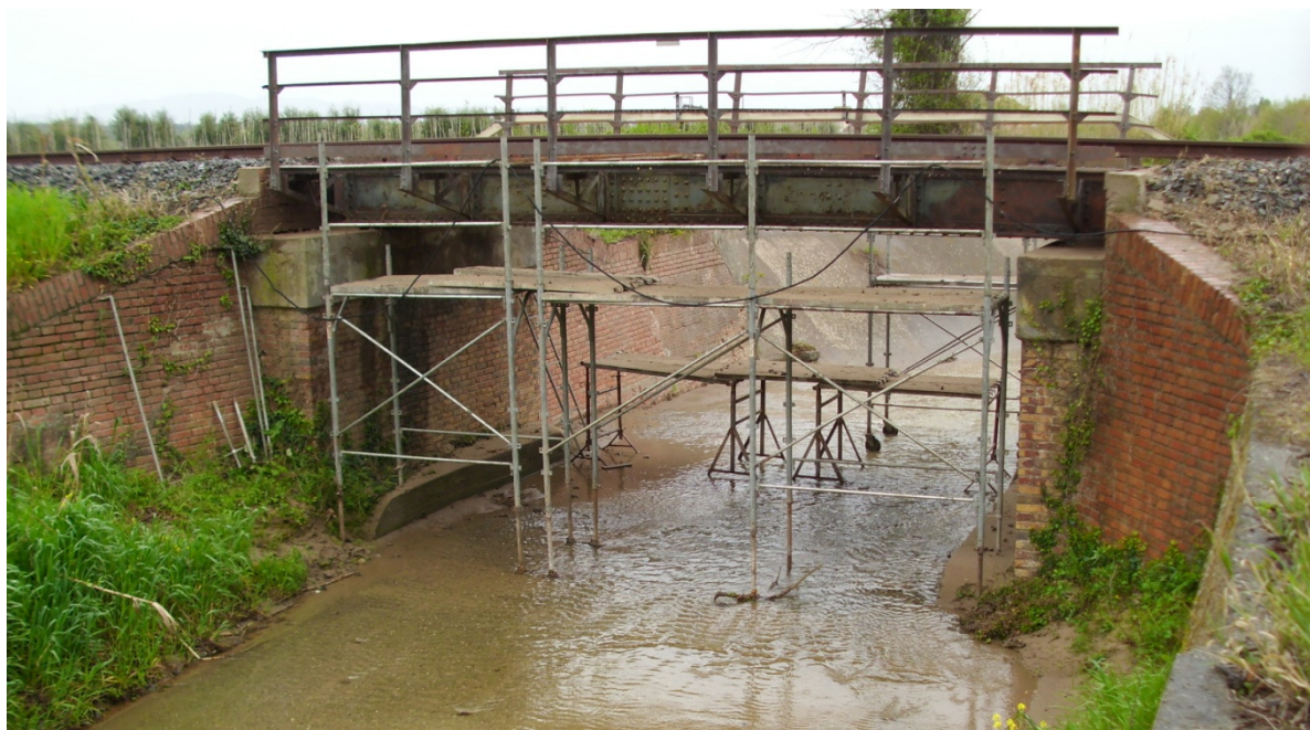
Figura 1 Vista del ponte lato valle
