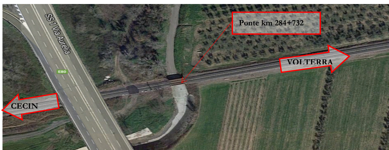
Figura 2 - Vista satellitare del ponte
