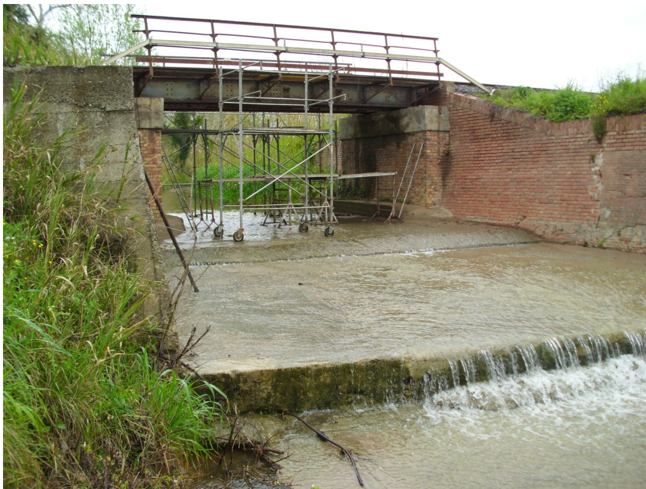
Figura 8 – Stato di fatto spalla lato Volterra
